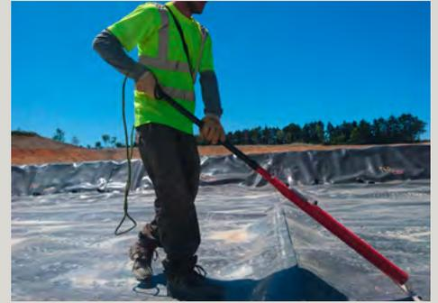
Composé d'un ensemble de balais électriques, générateurs et équipements adaptés aux différentes configurations, les outils AquaTT® et ArcTester (ASTM D7002 et D7953) permettent de répondre à la plupart des problématiques de détection de perforation sur géomembrane nue.
