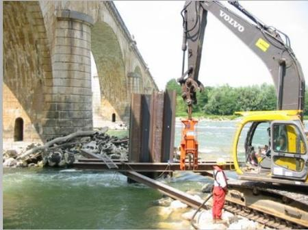
Les effets des vibrations (mécaniques ou explosif) sur un ouvrage comprennent les effets directs (fissuration...) résultant de la mise en résonance par les vibrations entretenues ou d'excitation à niveau élevé et les effets indirects par densification du sol.
