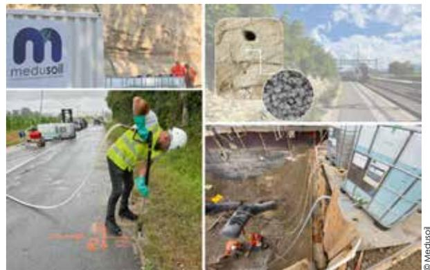
**Figure 5 : Application du biocoulis dans différents chantiers et conditions d'exécution.**
