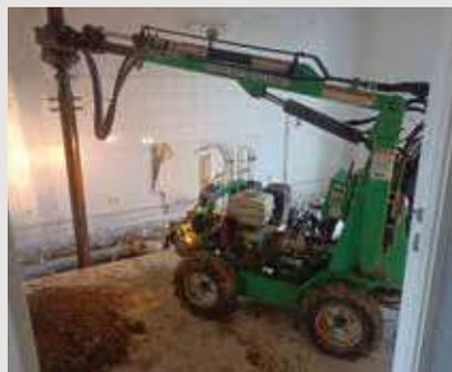
Les Techno Pieux sont vissés jusqu'à obtenir la pression nécessaire permettant la reprise de charge. Des rallonges sont soudées sur site pour descendre à la profondeur suffisante.
