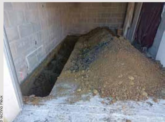
L'ouverture d'accès aux semelles filantes est réalisée au moyen d'une minipelle mécanique à l'extérieur et dans le garage, puis manuellement dans la maison.
