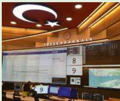
**2022, salle de contrôle de monitoring du pont 1915 Çanakkale en Turquie, le plus long pont suspendu du monde, plateforme instrumentation Geoscope/Beyond.**
