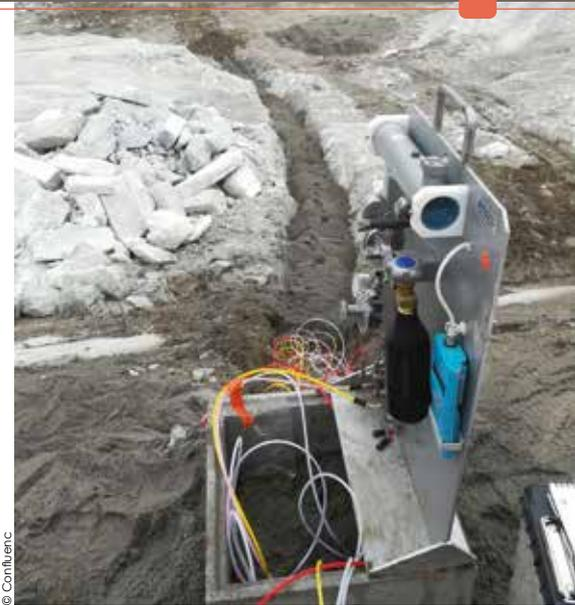
Photographie de la mise en place du suivi tassométrique – Mars 2022.
